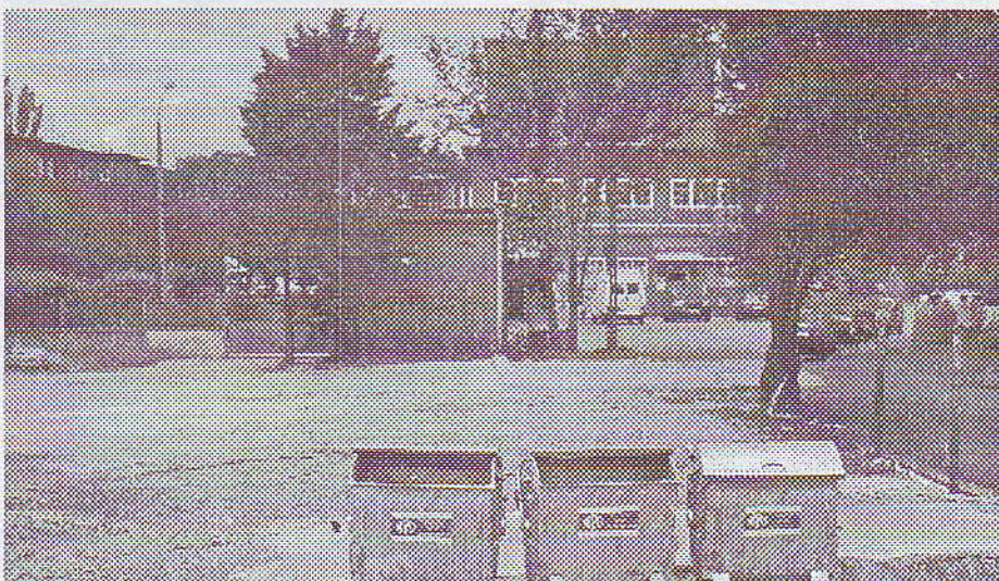
plac przy ul. Tarnogórskiej po wyburzeniach, czerwiec 2004 r.
